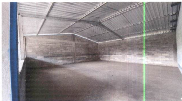
Foto 3: Area donde se contempla mejoramiento con estructura tipo potico e instalaciones de laminas troquelada calibre "26"
