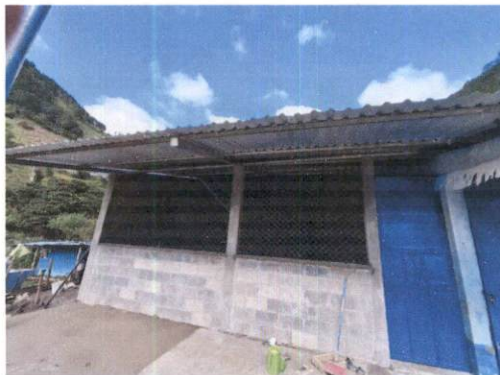
Foto 4: Area donde se contempla mejoramiento con estructura tipo potico e instalaciones de laminas troquelada calibre "26"
